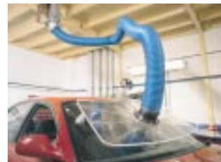
Punktutsuget använt för utsugning av ånga och rök vid byte av vindruta.
